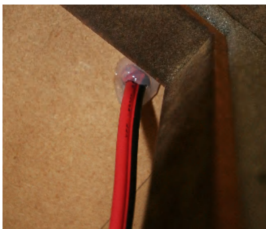
<左写真> 仕切板の配線貫通部のシリコンボンド充填の様子。
